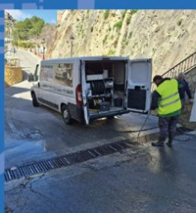
LIMPIEZA DE IMBORNALES
