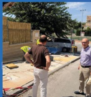
INTERVENCIONES EN ENTRECAMINOS
